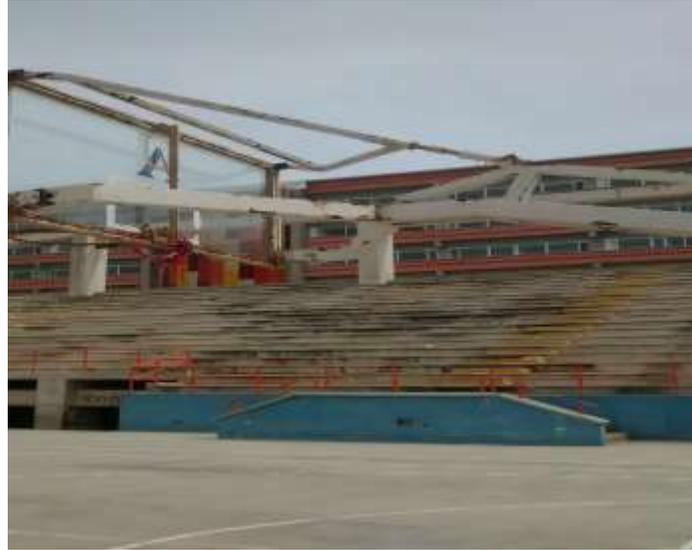
Estructura de la Cubierta del Coliseo (Empezando a oxidarse)
