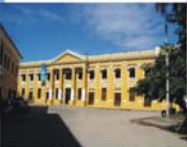
Ancien bâtiment de l'Douane
