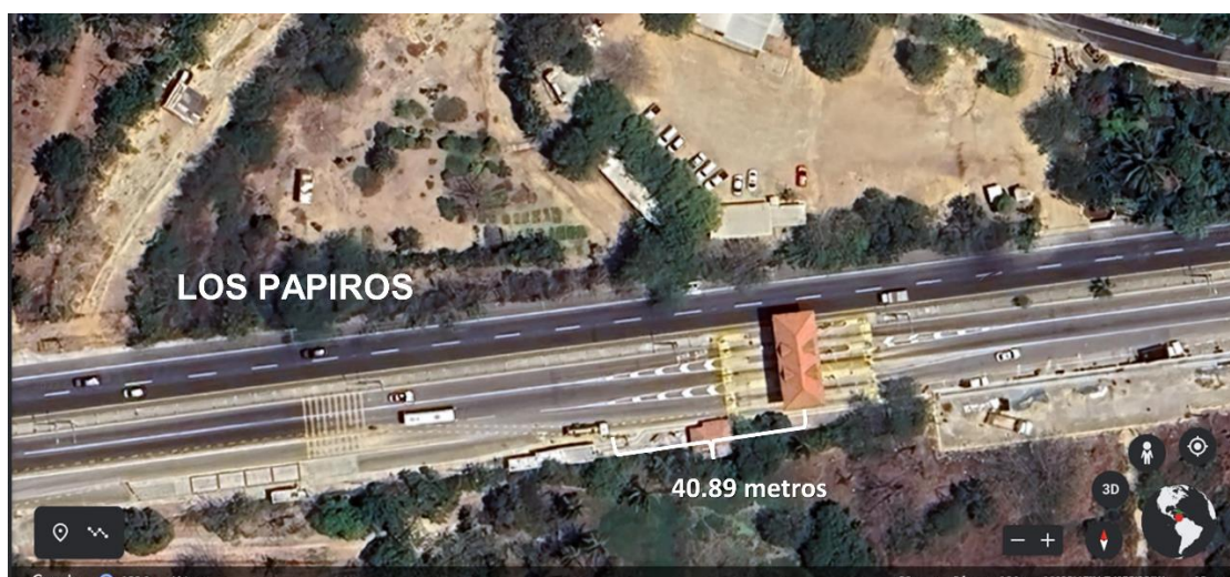
Ilustración 8. Aerofotogrametría Estación de control Los Papiros. Fuente Google earth, editado por el autor.
