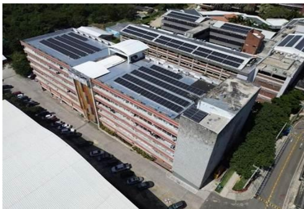
Ilustración 54. Instalación de paneles solares sede Norte.
