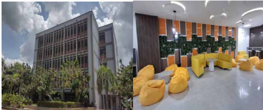
Ilustración 29. Mejoramiento Biblioteca Central
