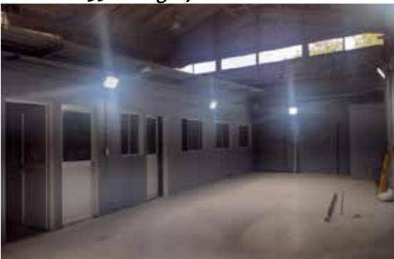
Proyecto de construcción y dotación del centro de mecanizado – sede Norte
